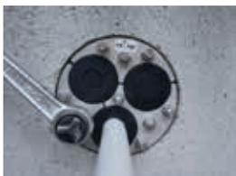
Sechskant-Muttern im Uhrzeigersinn in mehreren Schritten anziehen und das gleichmäßige Verpressen prüfen.
