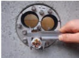
Kabel in Dichtung einsetzen:
