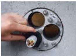
Den/die Zwiebeleinsätze am Rohr entlang in die Dichtung einschieben, bis sie bündig sitzen. Ggf. mit etwas Gleitmittel nachhelfen.
