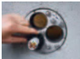
Den/die Zwiebeleinsätze am Rohr entlang in die Dichtung schieben, bis sie bündig sitzen. Ggf. mit etwas Gleitmittel nachhelfen.
