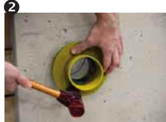
Die **Connector Anschlussdichtung** mit einem Gummi- oder Kunststoffhammer gleichmäßig einschlagen, bis die Dichtung bündig an der Bauteiloberfläche anliegt.
