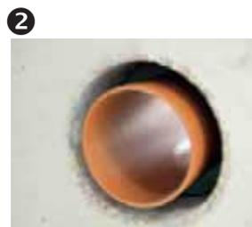
Das KG-Rohr komplett durch die Dichtung schieben und die Spannschelle mit einem Ringschlüssel handfest anziehen
