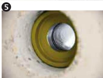
Das Wellrohr ist jetzt druckwasserdicht an die Kernbohrung / das Futterrohr angeschlossen
