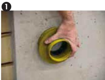
Die **Connector Anschlussdichtung** wird in der Kernbohrung / im Futterrohr positioniert
