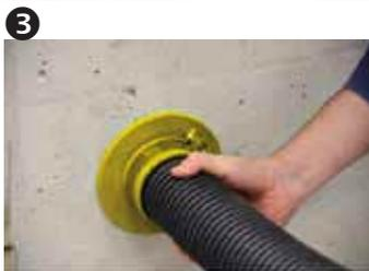
Anschließend die Spannschelle über die Anschlussdichtung legen und das anzuschließende Wellrohr bis zum Anschlag in die Anschlussdichtung einschieben.
