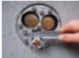
Kabel in Dichtung einsetzen:
