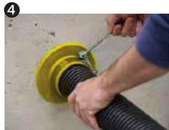
Danach die Spannschelle handfest anziehen und somit das Wellrohr sichern.
